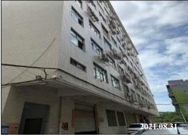
项目厂房外观
