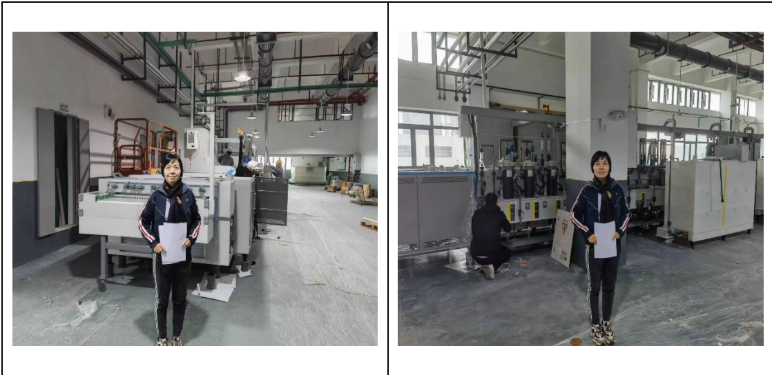
工程师现场勘查车间内现状图
